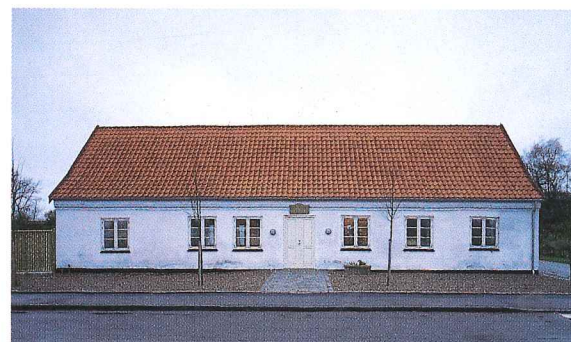
Rytterskolen i Store Rørbæk. Bygningen er blevet gennemgribende istandsat, og skorstenene savnes.
