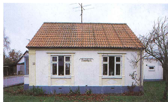
Byvej 37. Byggestilen er inspireret af historicismen med pilastre på hjørnerne og indfatninger med blændingsfelter. Ved en fremtidig tagomlægning kunne man ønske, at skorstenene ville blive genopbygget.
