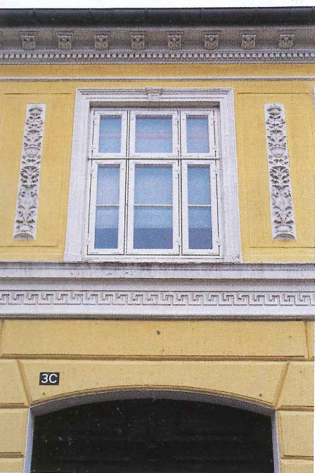
Østergade 3C. Stukfriser, -indfatninger og mæanderbånd er dekorative elementer på flere af byhusenes facader.
