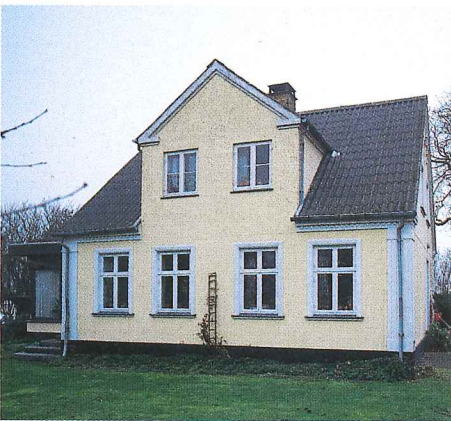
Stuehus til husmandssted, Apholm 3. Opført 1914, frontgavl tilbygget 1940. Bygningen har klassicistisk inspirerede hjørnepilastre og pudsede indfatninger om vinduerne – der i øvrigt er de originale. En fin helhed.
