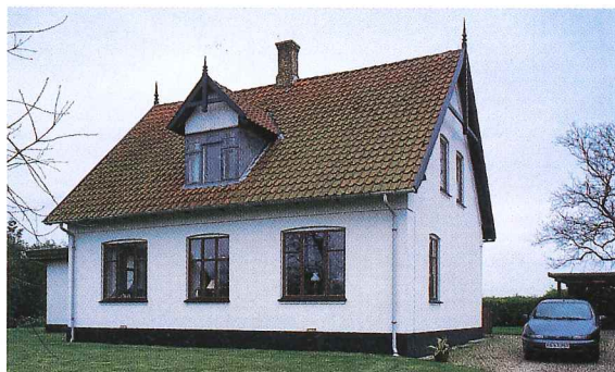
Sigerslevvestervej 52. Bygget 1928. Kvistvinduer og skorsten er fint bevaret. Tagets detaljer har nationalromantisk islæt og giver huset karakter.
