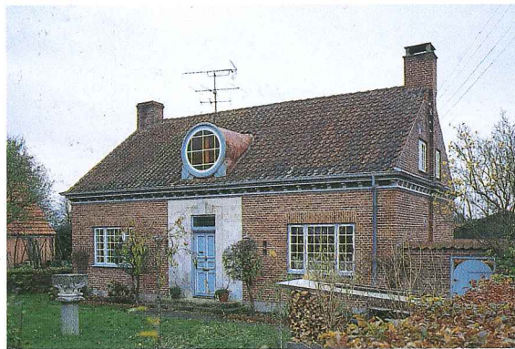
Roskildevej 122. Bygget i 1929. Husets midterparti fremhæves af den karakteristiske, runde kvist over døren med pudset indfatning. Bemærk, skorstenenes placering i gavlene efter engelsk mønster.
