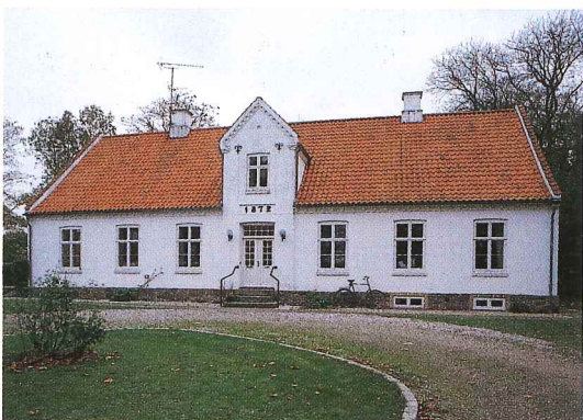
Græse Præstegård bygget 1872. Med stilpåvirkning fra borgerskabets villaer i byen, men samtidig blot et velformet stuehus. Bykultur og landkultur mødes.
