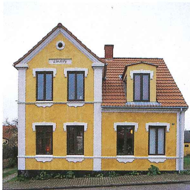
Lindealle 5. Bygget 1905 i historicistisk stil. Den lille villa er fornemt dekoreret med svungne former i de pudsede indfatninger om vinduerne, markering af hjørnerne og bånd. En fintformet skorstenspipe er bevaret i tagryggen.
