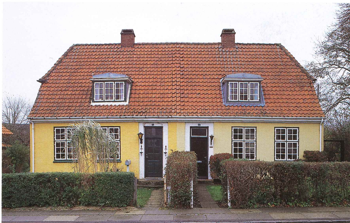
Mariendalsvej 5a og b. Opført 1920 i Bedre Byggestil. Ark. Norup og Klein, Hellerup. Det er vigtigt at bevare de originale vinduer og kviste samt – hvor det stadig er muligt – de originale fyldingsdøre. Ligeledes bør dobbelthuset stå som eet hus med samme farver og detaljering.
